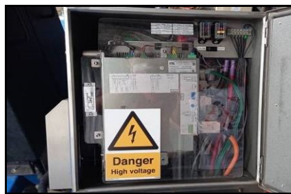
ภาพที่ 3 ตู้ควบคุมระบบไฟฟ้าและระบบสายสัญญาณ
