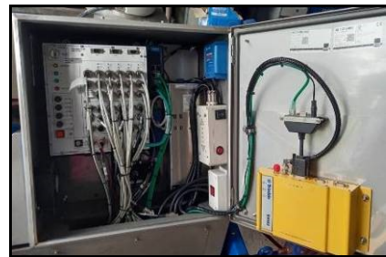
ภาพที่ 3 ตู้ควบคุมระบบไฟฟ้าและระบบสายสัญญาณ
